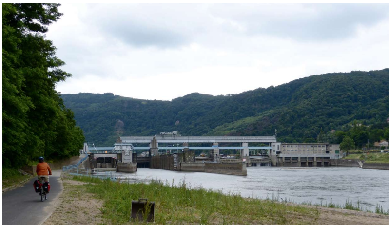
Bild 1: Das Elbestauwerk bei Ústí nad Labem mit 10,36 m Stauhöhe
