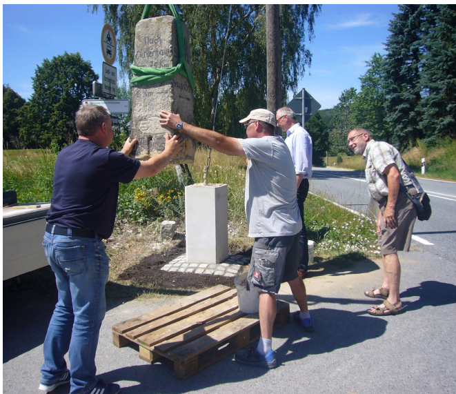
Der historische Teil der Säule wird auf den neuen Sockel aufgesetzt.
