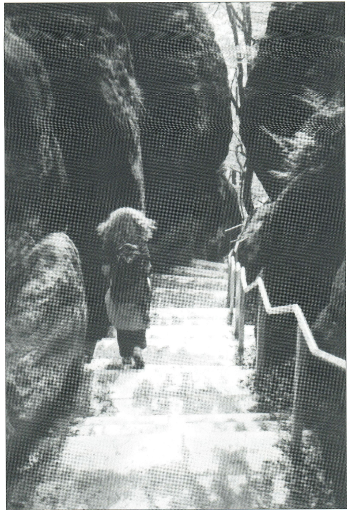
Edelstahlgeländer am Aufstieg auf die Bastei Foto: Reinhard Wobst
