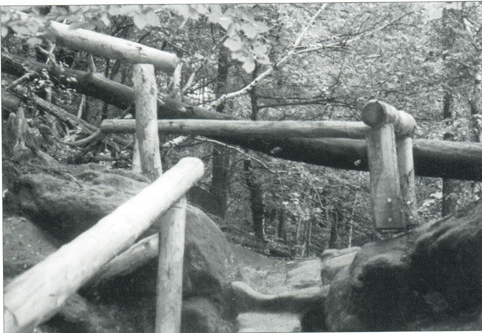
In den Felsuntergrund eingebohrte Geländerpfähle in leichtem Gelände (Breite Kluft) Foto: R. Wobst
