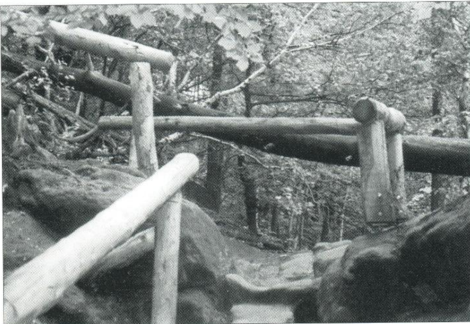
In den Felsuntergrund eingebohrte Geländerpfähle in leichtem Gelände (Breite Kluft) Foto: R. Wobst
